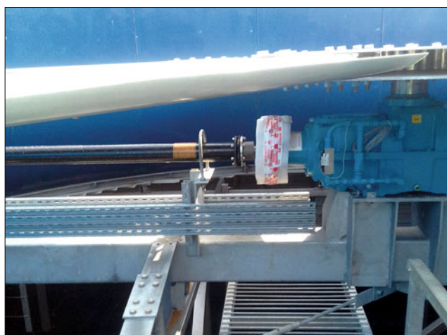
Рис. 2. Градирня с выносным приводом по схеме мотор – вал – редуктор (ОАО “Гродно Азот”, г. Гродно, Республика Беларусь)
